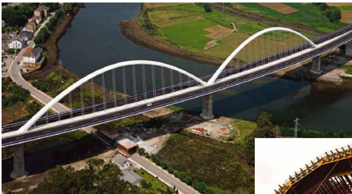
Виадук через р. Навиа, Испания Подрядчик - FCC Construcción, S.A. Субподрядчик по натяжению - BBR PTE Конструктор - Техслужба FCC Construction, S.A.
