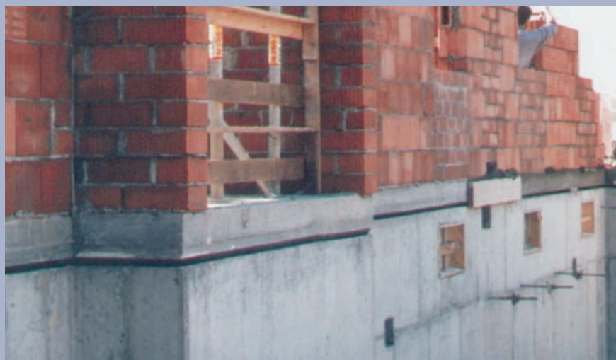
Рис. 2: Усиленный и законченный горизонтальный стык
