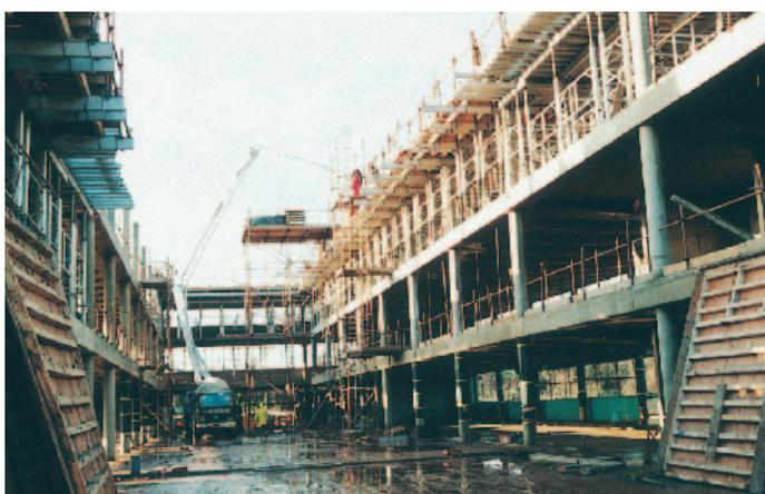
На рисунке представлена рамная несущая конструкция из монолитного бетона, в которой применено кессонное перекрытие. Для передачи поперечных усилий через температурные швы перекрытия были применены двойные штыревые анкеры. Благодаря этому отпала необходимость в дополнительных колоннах в местах швов. Фирма, выполнявшая строительные работы, оценила, в частности, скорость и простоту монтажа двойных штыревых анкеров.
