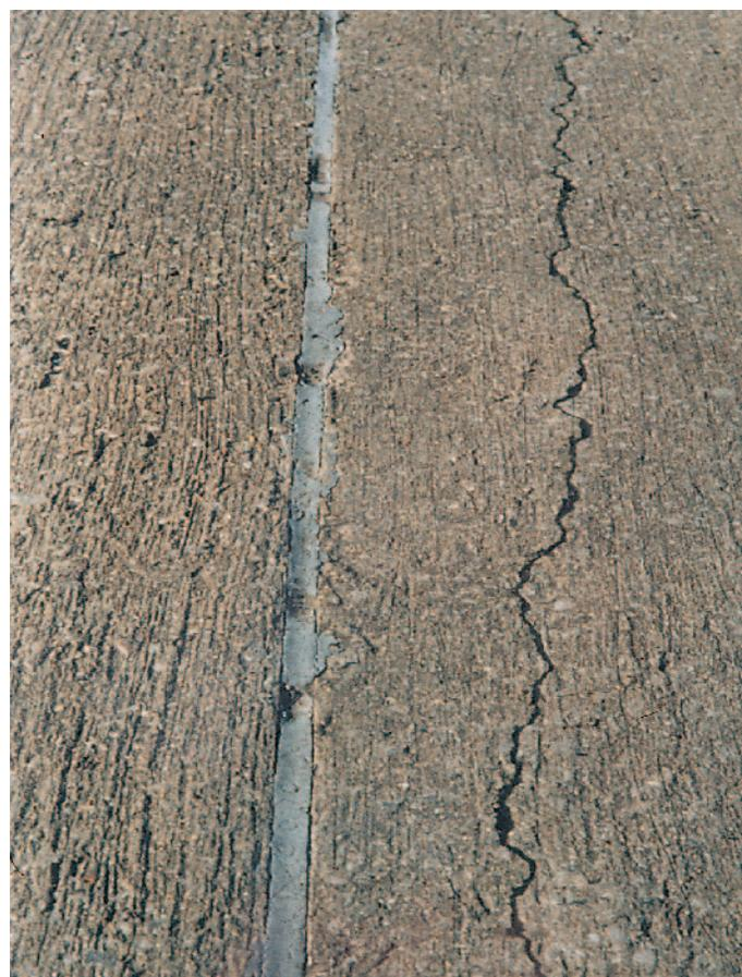
Образование трещин в бетоне за пределами температурного шва
